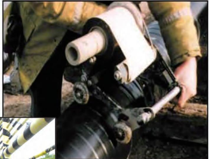
▲ Densoclad 40HT Tape로 테이프 감는 기계로 사용하여 작업하는 모습(기계는 별도구매 가능)
